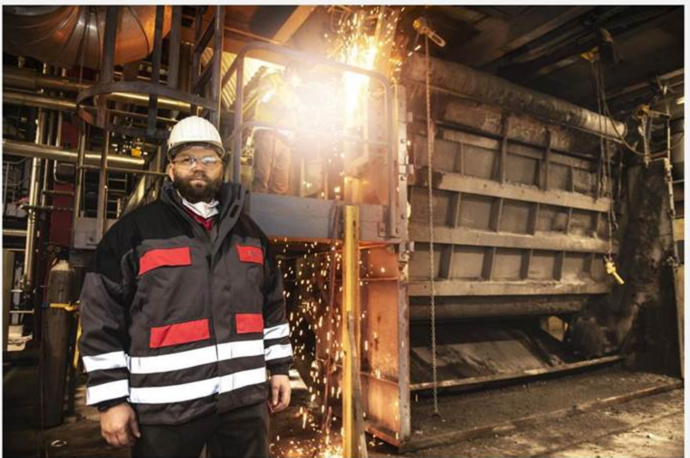
Betriebsassistent Hans Linsmeyer vor dem Entschlacker. Foto © EVN Matejschek
